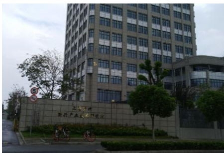
园区大门及本项目厂房
