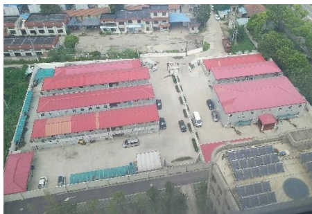
北侧 工业性厂房
