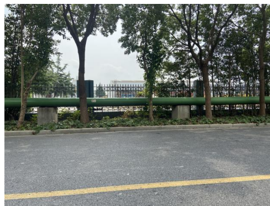
项目厂区南侧 元电路
