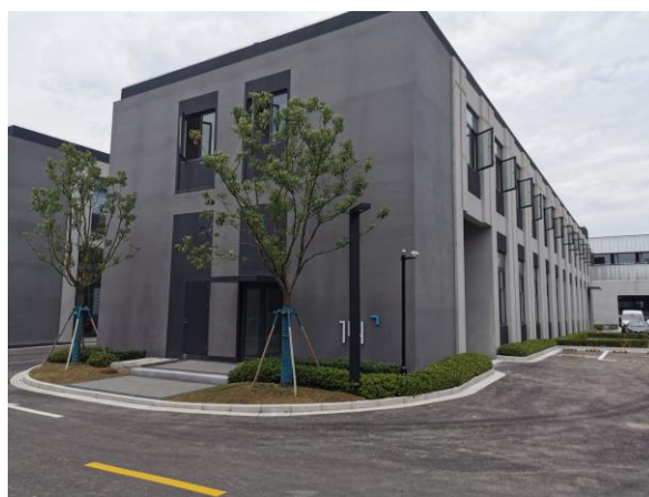
本项目所在建筑
