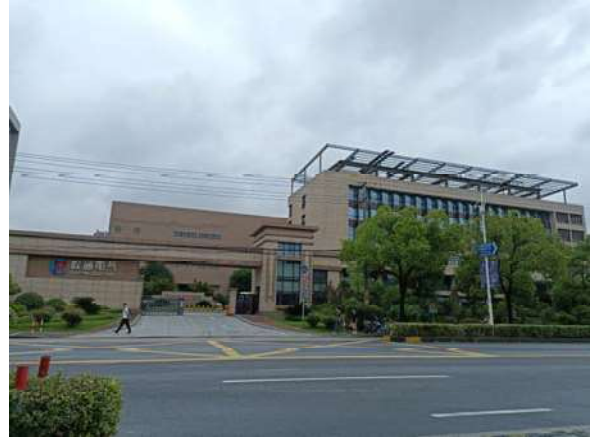
北侧：欧通电气园区
