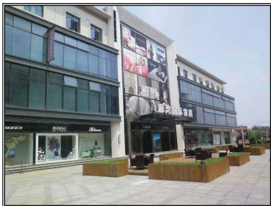
本项目所在建筑
