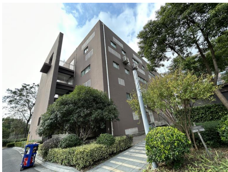
项目西侧（37号楼）
