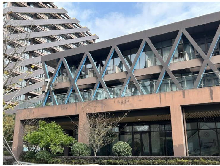
项目东侧（7号楼）
