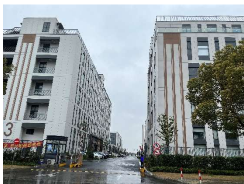
本项目所在厂区大门
