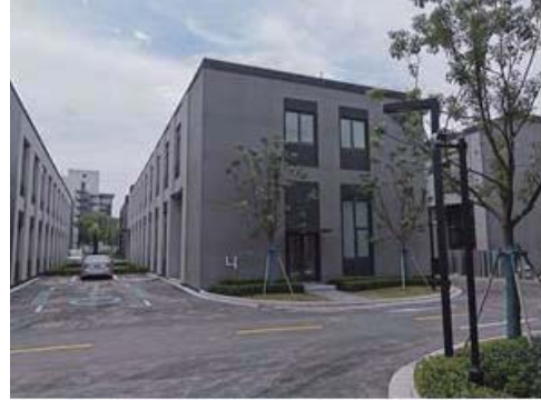
本项目所在建筑
