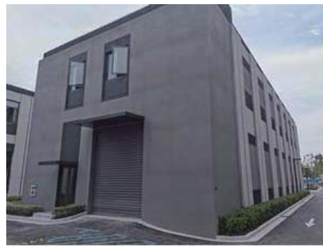
北侧：园区6#楼（拟引进上海睿制开源实验室装备有限公司）
