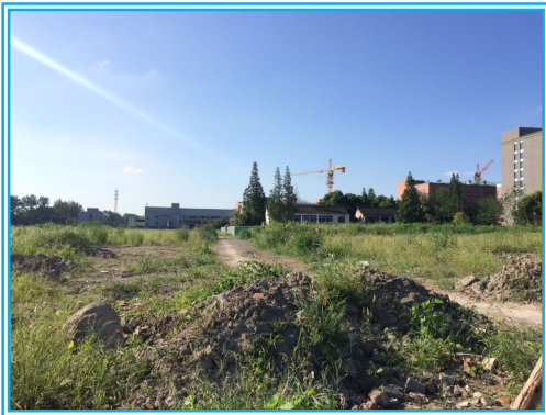
东侧：上海宏笙工贸有限公司施工工地
