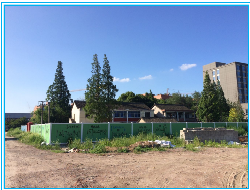
北侧：光明村待拆迁民宅（距离约 80m）
