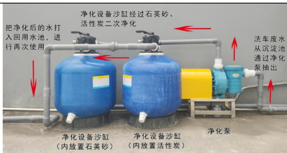
图 4-1 污水处理循环使用设备示意图
