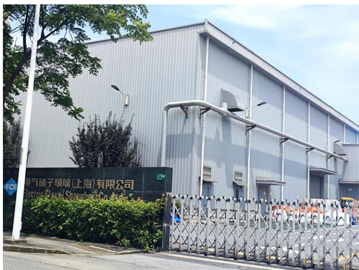
项目西侧：电气硝子
