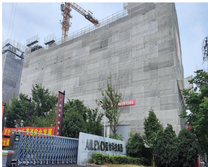
项目南侧：标准厂房施工工地
