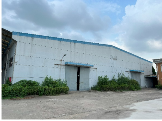
本项目 5 幢厂房(废弃混凝土)
