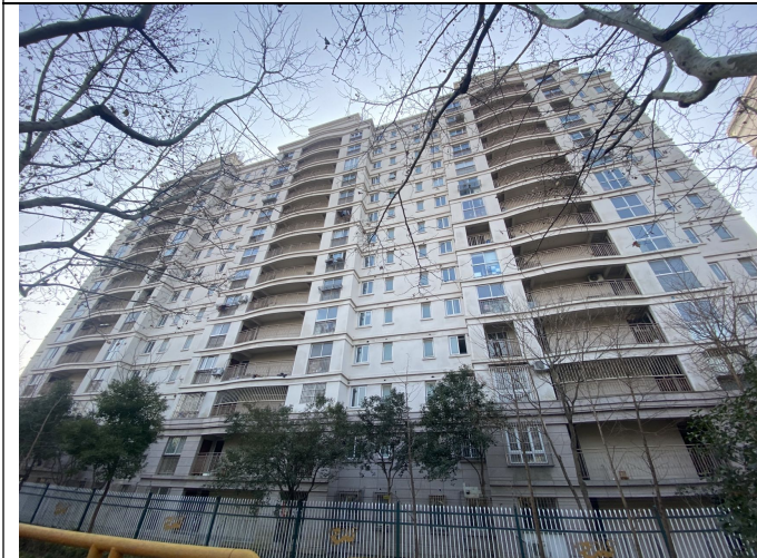
项目西侧居民楼
