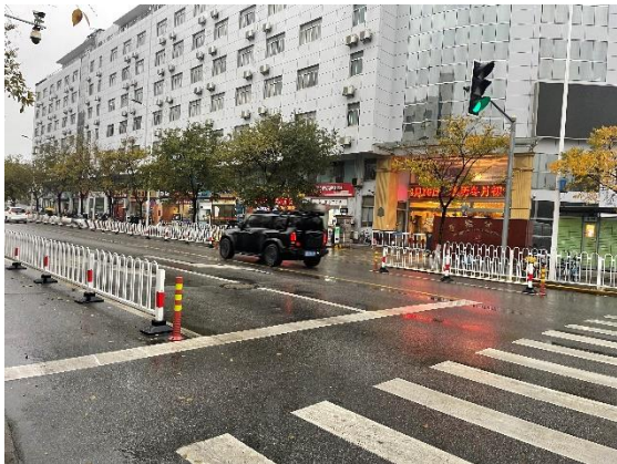
项目厂区西南侧繁安路及亨诺公寓
