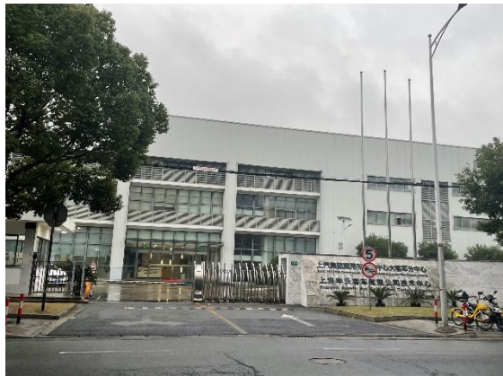
项目厂区西北侧光中路及上海申沃客车有限公司
