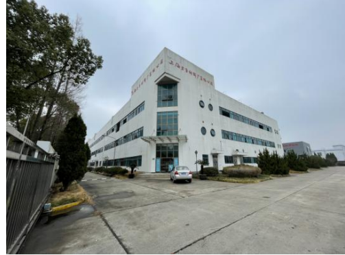
厂区内南侧：1幢
