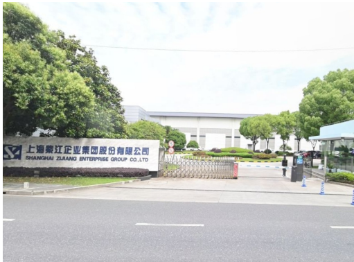
厂区外东侧：紫磊环路
