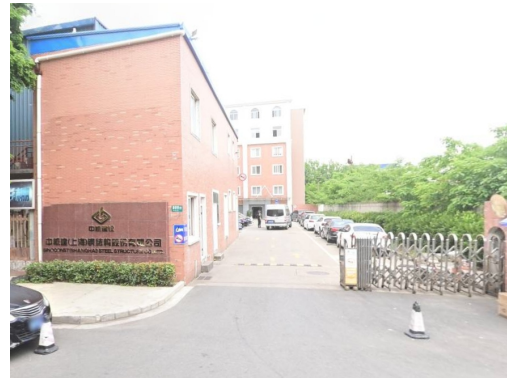
厂区外西侧：中机建（上海）钢结构股份有限公司
