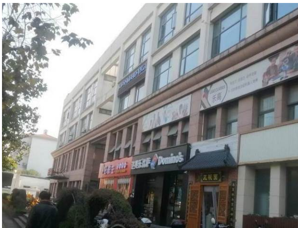
建筑东侧沿街商业建筑
