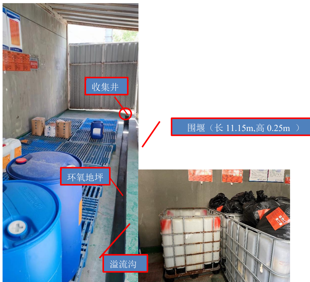
危废暂存间（左：液体危废暂存间 35m 2 ，右：固体危废暂存间 15m 2 ）
