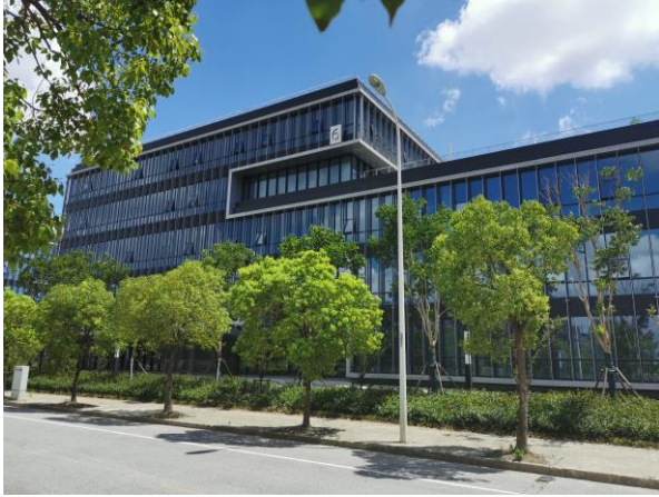
北侧：绿洲环路 396 弄 6 号楼
