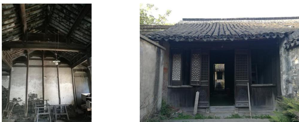
三、区文物保护点胡信义商号住宅，徐凌村 1 组 86 号，所有人为浦江镇投资发展有限公司。目前，胡信义商号住宅的文物本体损毁严重。楼板和屋顶几乎完全毁坏、木构件腐朽、墙面发霉，整体结构松动，有随时坍塌的可能。并且，文物本体内堆积了大量的杂物，有消防安全隐患，急需修整。
