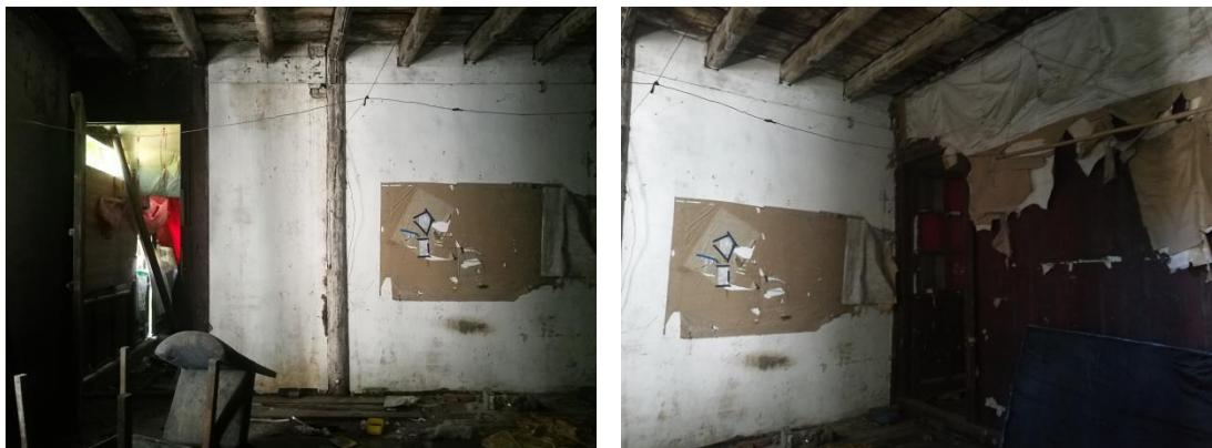
四、区文物保护点秦家住宅，陈行村 1 组 97~112 号，所有人为浦江镇投资发展有限公司。目前，秦家住宅多处墙体坍塌，外墙出现多条裂缝，墙面剥落严重，木构件残损严重，结构稳定性差，急需修整。
