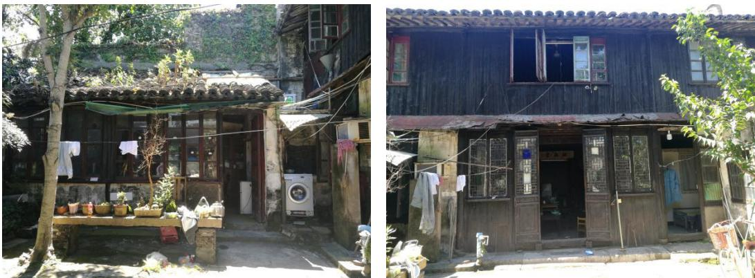
二、区文物保护单位胡氏三寿堂宅院，陈行村1组71号，所有人为胡振庭。目前，胡氏三寿堂宅院的墙体渗水、屋顶漏水、局部墙面剥落、木构件腐朽，导致多处结构松动，可能将危及宅院的整体安全。建议镇政府告知产权所有者予以加固。
