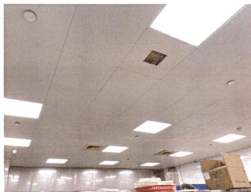
图 2.3.3-2 节能灯具现场照片
