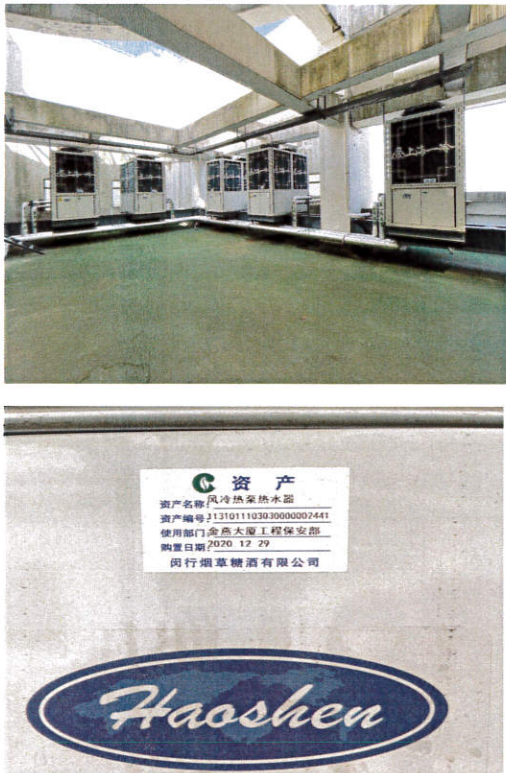
图 2.2-2 风冷涡旋热水机组现场照片
