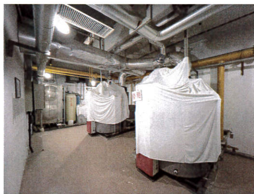
图 2.3.3-1 废弃锅炉现场照片
