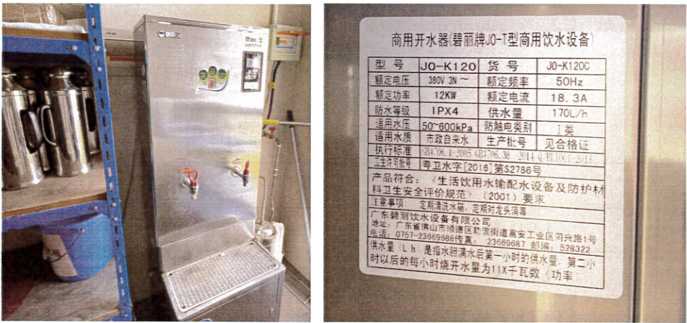
图 2.2-8 开水器现场照片
