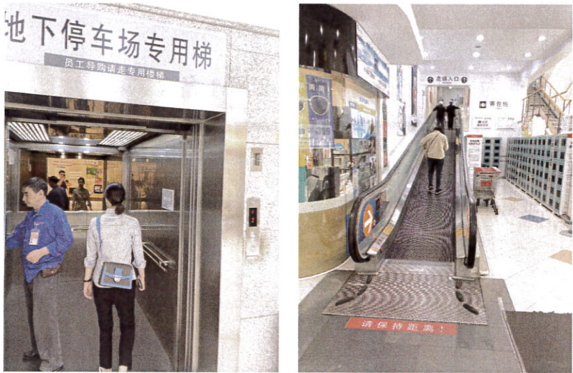
图 2.2-8 电梯现场照片
