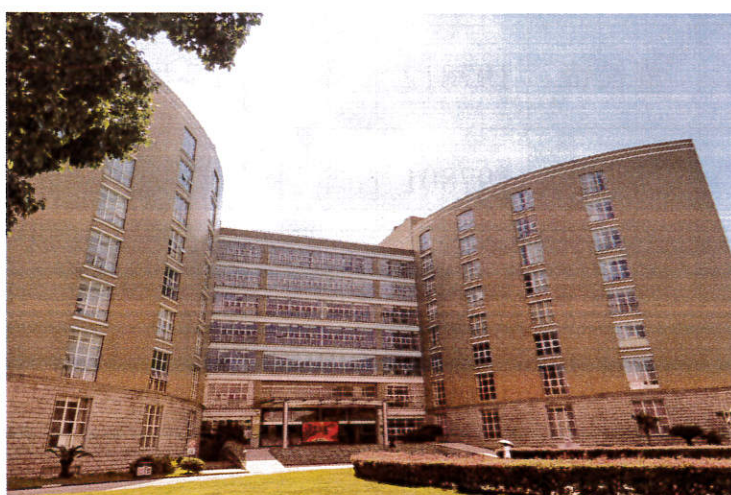
图 2.1-1 图文信息大楼（东海源）外观照片
