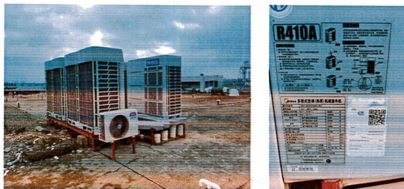
图 2.2-1 风冷式热泵机组现场照片
