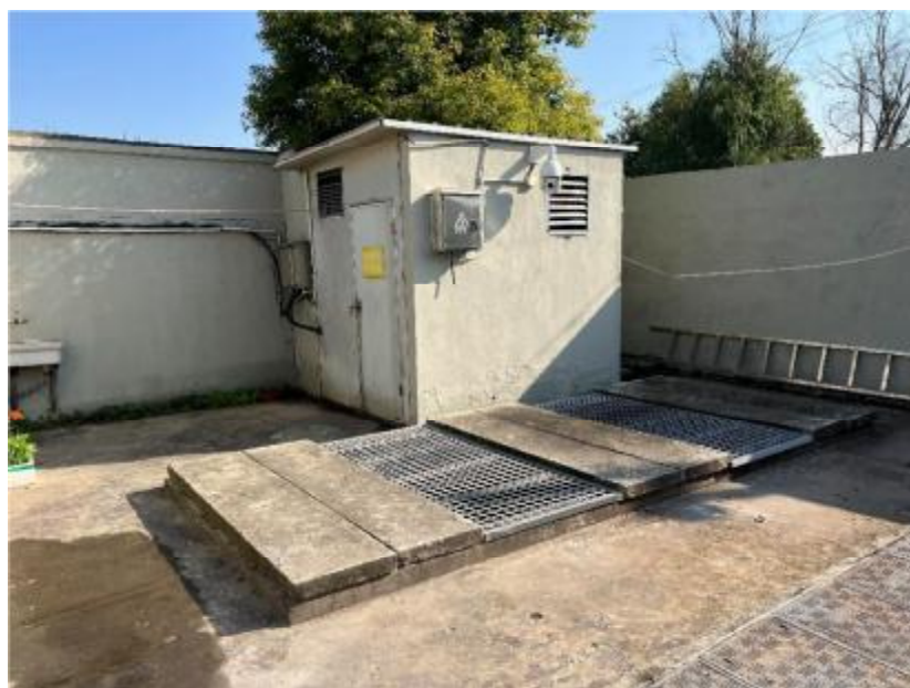
图 1.5-8 现状照片 1（泵站集水池）
