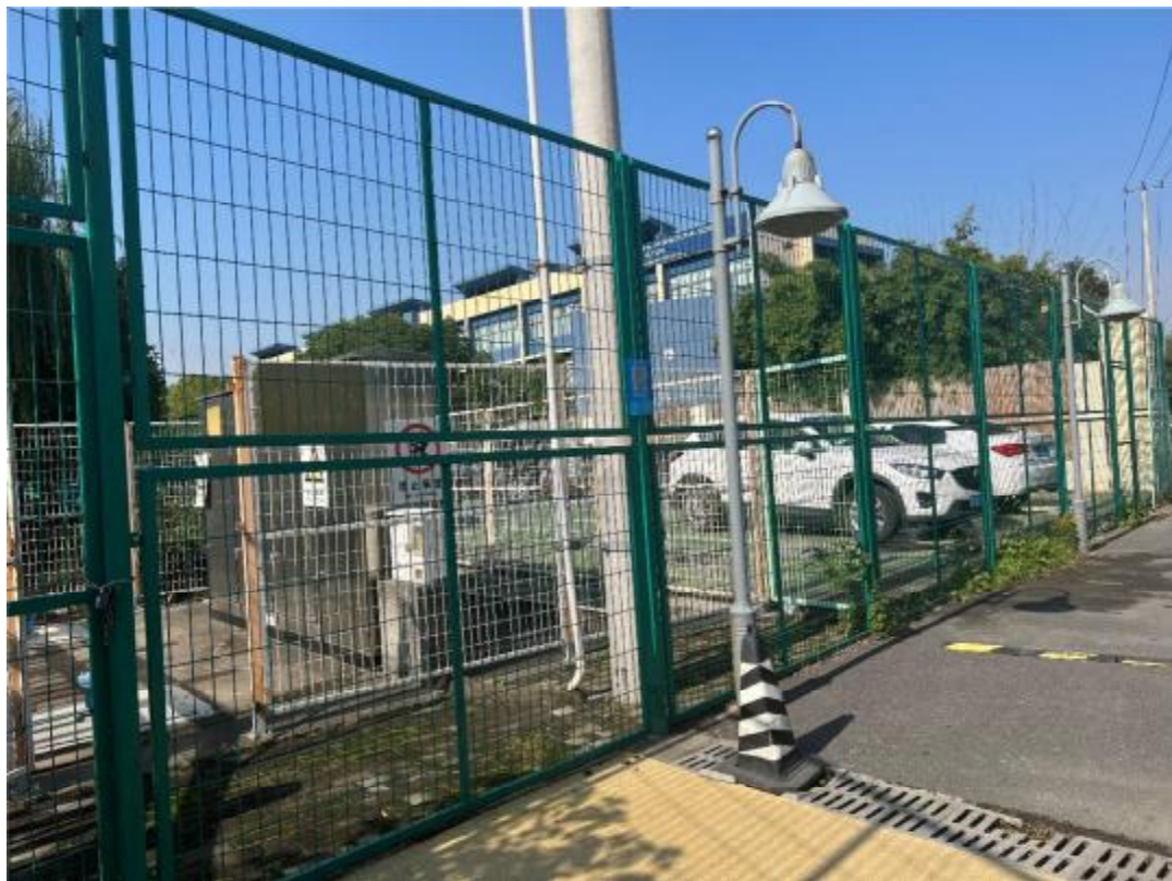
图 1.5-3 现状金光路泵站
