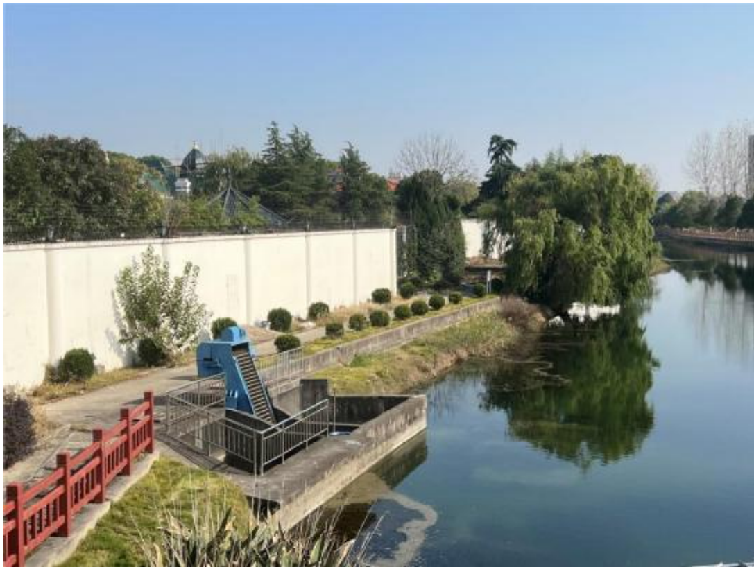
图 1.5-2 现状西郊庄园南侧泵站
