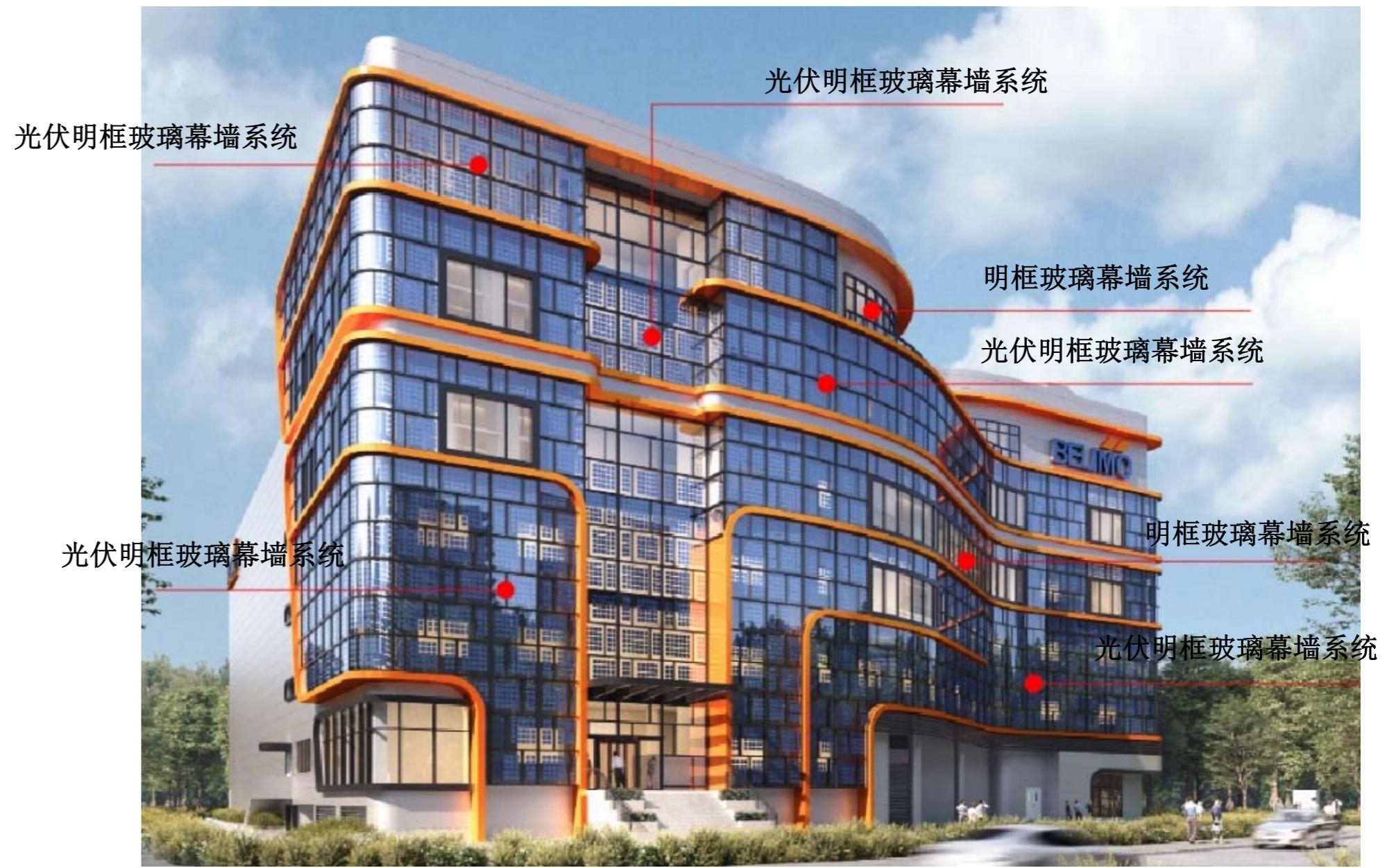
建筑外立面采用光伏中空夹胶玻璃，与铝板线条搭配，提高了幕墙外部肌理，强化视觉感官，使外立面富有韵律，更有层次感。玻璃幕墙采用全明框系统，层间采用铝板幕墙，可提高幕墙稳定性和安全性。
