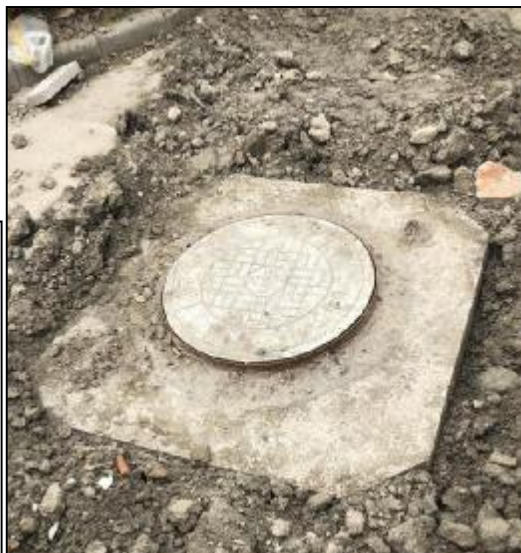
图 6.3-6 塑料检查井防护井盖
