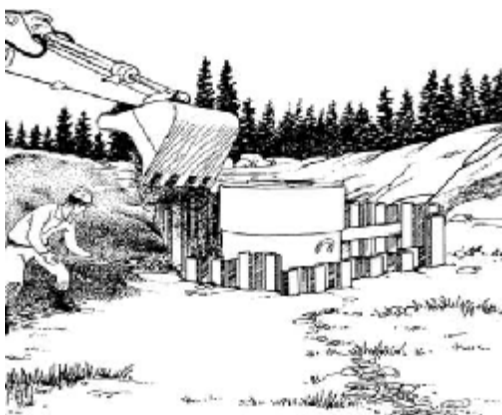
图9.2-9 回填及回填后效果图
