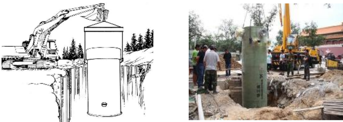
图9.2-7 泵站吊装图
