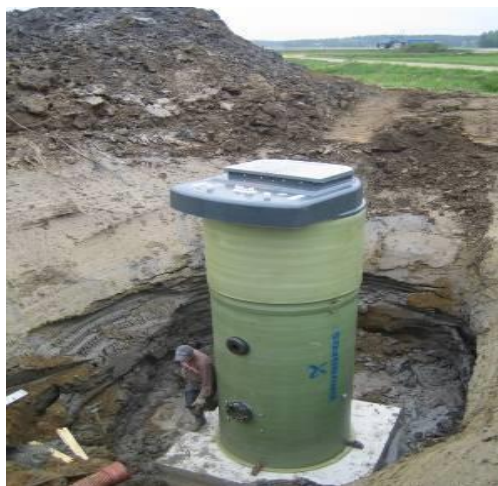
图9.2-8 安装井筒图
