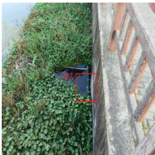
图2.4-12 墙华湾排口处
