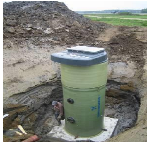
图9.2-8 安装井筒图
