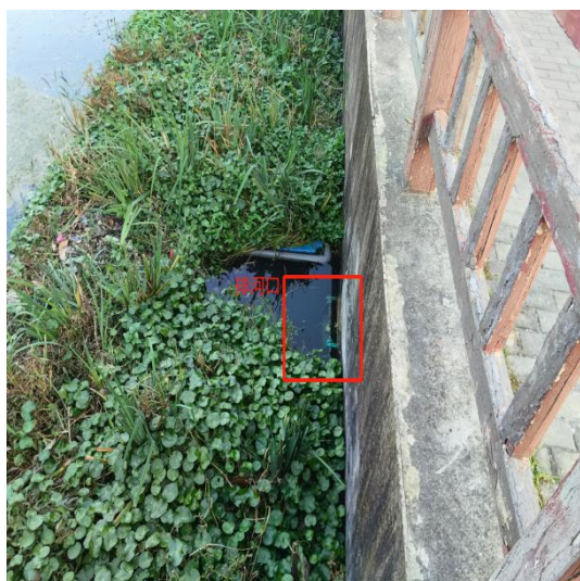
图2.4-12 墙华湾排口处
