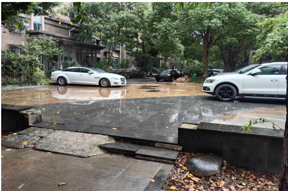
图2.4-10 小区两侧道路与中心积水区域连通处（存在高差）
